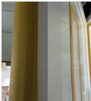
Positionnement de l'adhésif ORANGE sur la tranche de la porte.
